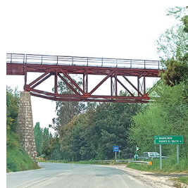
Arriba: Puente Ferroviario Magdalena, Coelemu. Abajo: Puente Ferroviario El Salto, Guarilihue.
